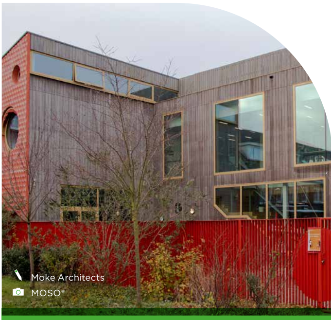
École Primaire Publique "IKC" photo prise 5 ans après l'installation (320 m 2 ) Amsterdam, Pays-Bas
